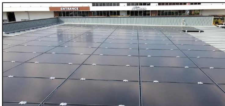
※屋根に設置の太陽光パネル
